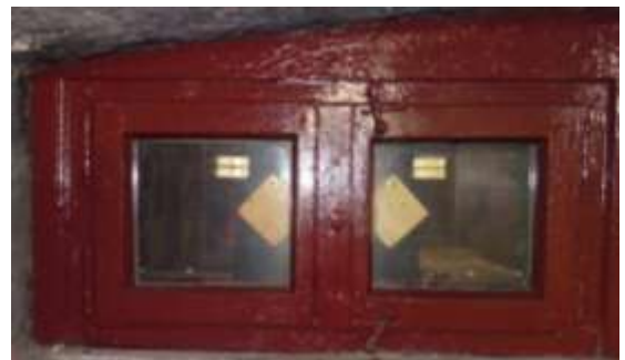
Ansicht: Innen im Dachboden.
