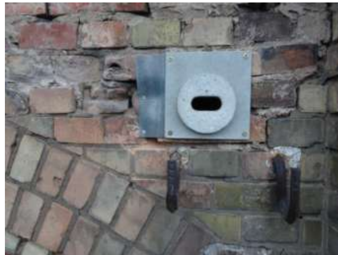
Nachher = ein Mauersegler-Nistplatz. Seitlich haben wir es noch mit einem Stück Zinkblech abgedichtet.
